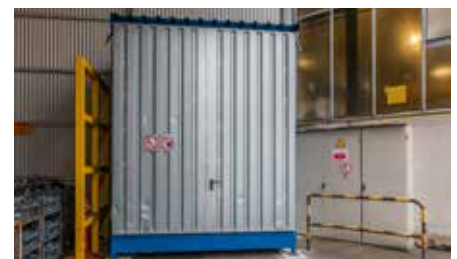
Gefahrstoffschränke mit Anfahrerschutz
