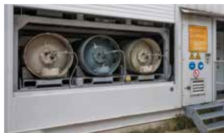
Chemikalienlager – Ammoniakbehälter
