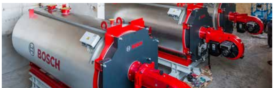
2017 neu eingerichtete Heizkessel im Heizhaus (Bild noch während des Aufbaus)
