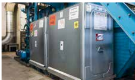
Gefahrstoffe – Doppelwandige Behälter
