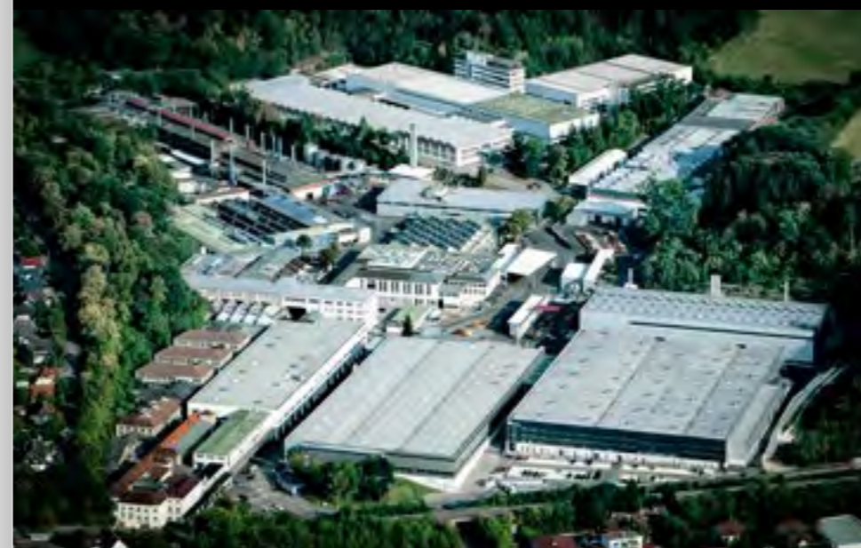
LUFTAUFNAHME DER MASCHINENFABRIK ALFING KESSLER GMBH
